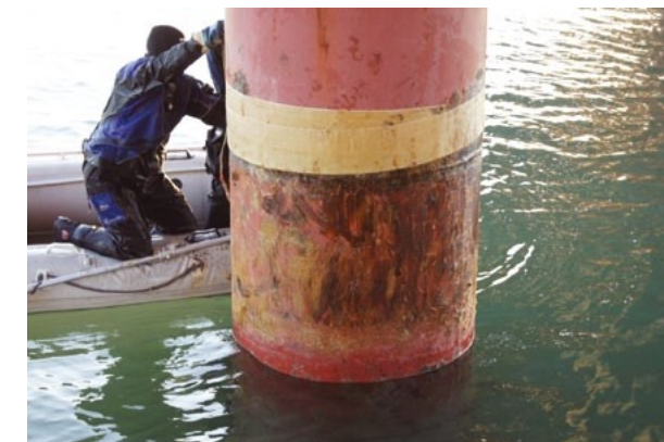
Рис. 8. Нанесение ленты на надводную часть сваи
