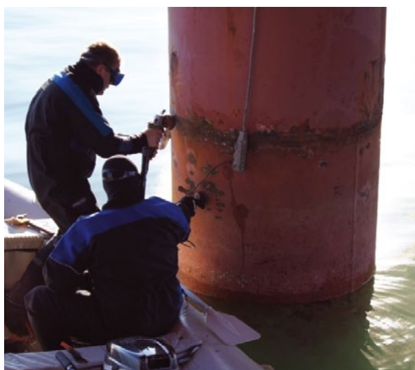
Рис. 6. Очистка поверхности
