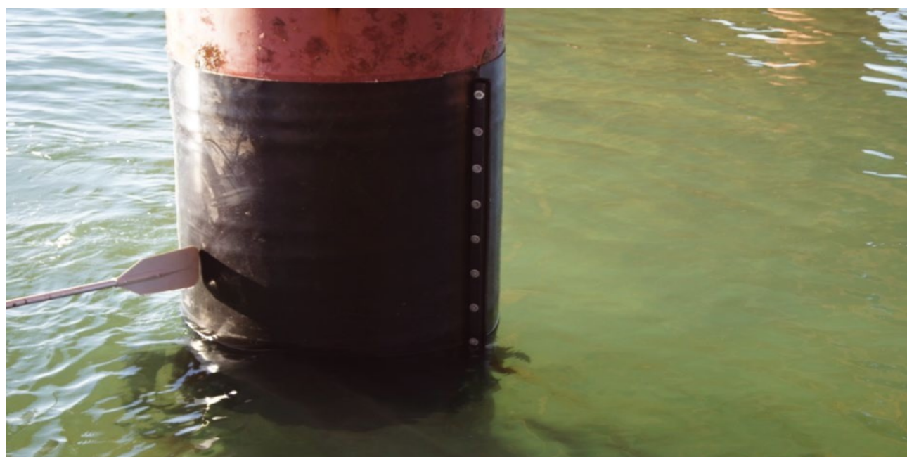
Рис. 11. Система MarineProtect®-2000FD после монтажа
