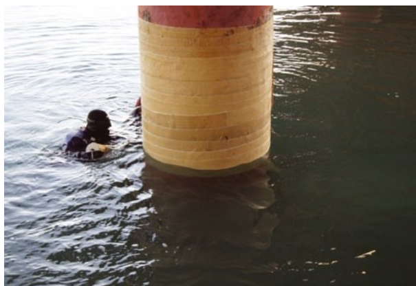
Рис. 9. Нанесение ленты на подводную часть сваи
