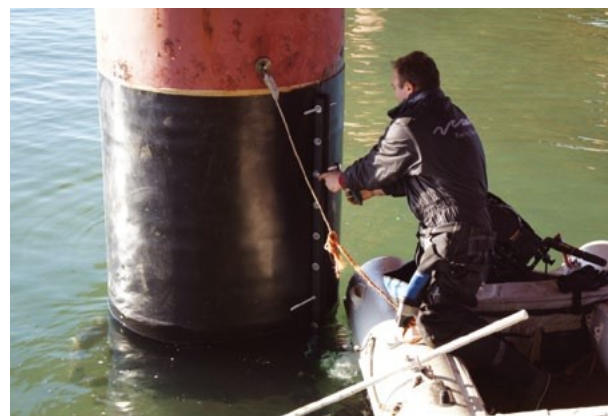
Рис. 10. Установка кожуха
