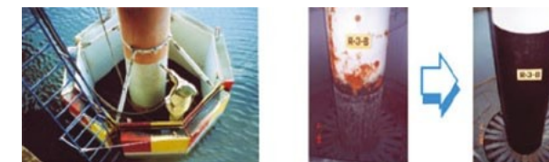
Рис. 3. Ремонт свай с использованием кессонов
